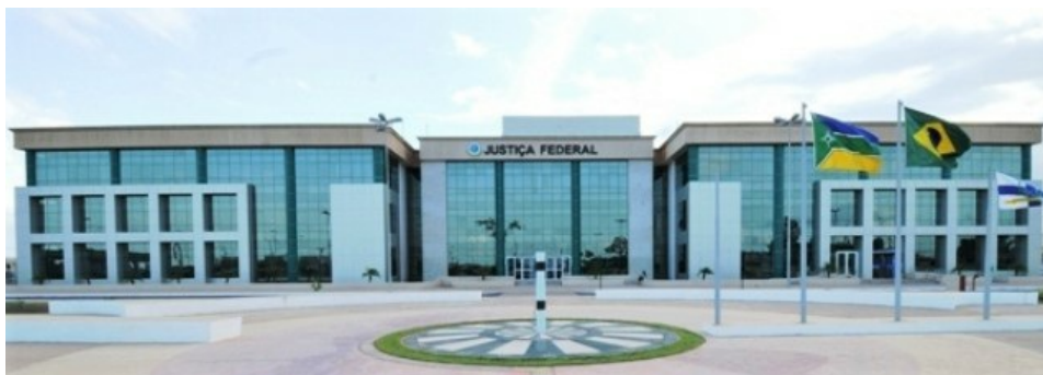
Fachada do edifício sede da Seção Judiciária do Amapá
