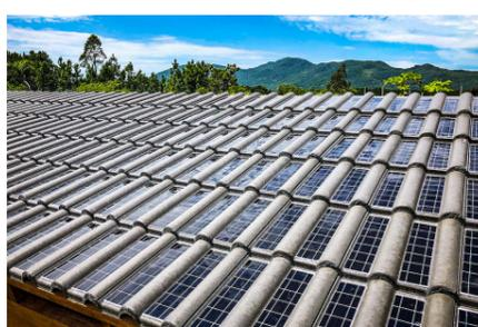
Inéditas no Brasil, as primeiras telhas solares já foram vendidas para clientes selecionados no Estado de São Paulo e próximos à unidade fabril, em Atibaia. O grande diferencial das telhas solares é a fácil adaptação às construções existentes, já que sua instalação é quase a mesma de uma telha de concreto convencional. As telhas solares também são esteticamente mais harmoniosas quando comparadas aos painéis solares. (Fonte: [ciclovivo.com.br](http://ciclovivo.com.br) | @ciclovivo)
