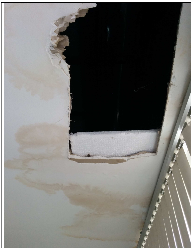
Foto 1 – Vista do forro do setor de RH, degradado por infiltração, decorrente da oxidação nas calhas.
