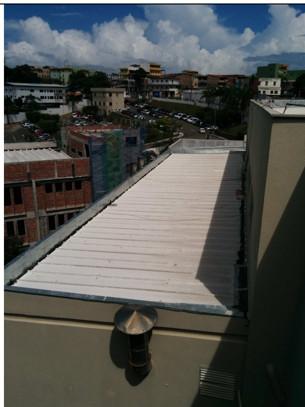
Foto 6 – Vista superior do telhado do Restaurante.
