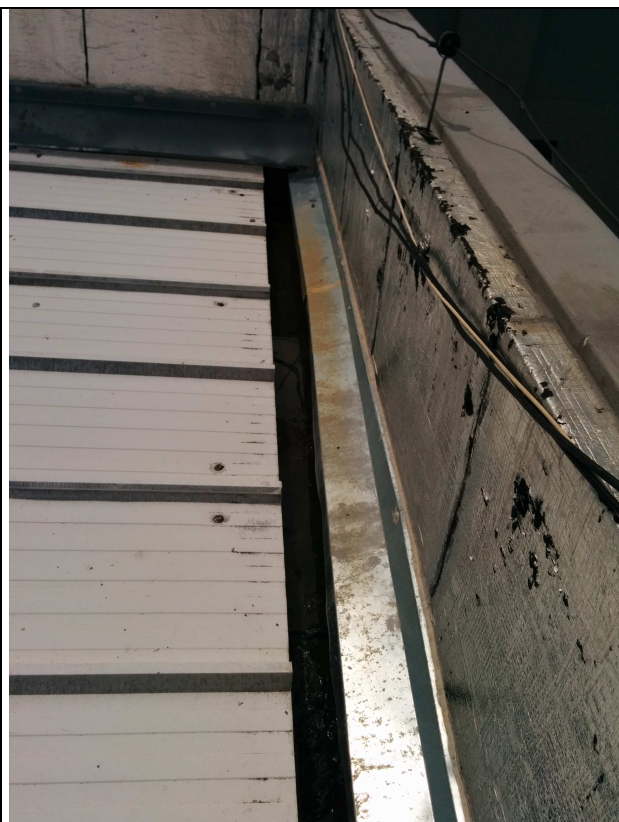
Foto 2 – Vista dos rufos oxidados e manta degradada.
