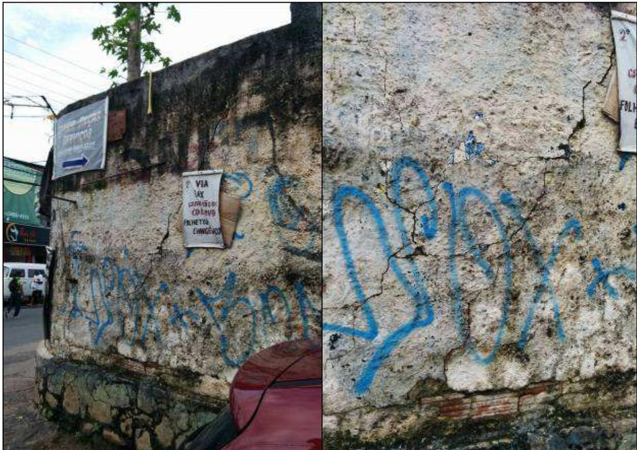
Vista externa do muro – Parte a ser demolida e reconstruída.
