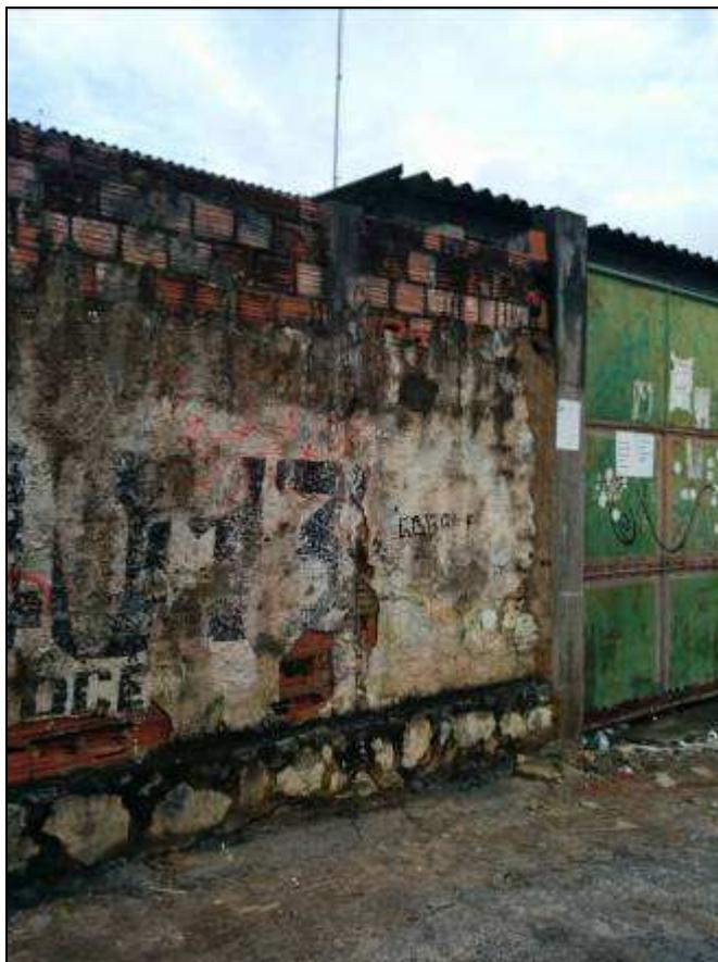
Vista externa do muro – Coluna a ser restaurada e alvenaria a ser chapiscada.
