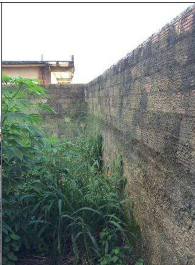
Vista interna do muro – Parte a ser demolida e reconstruída.
