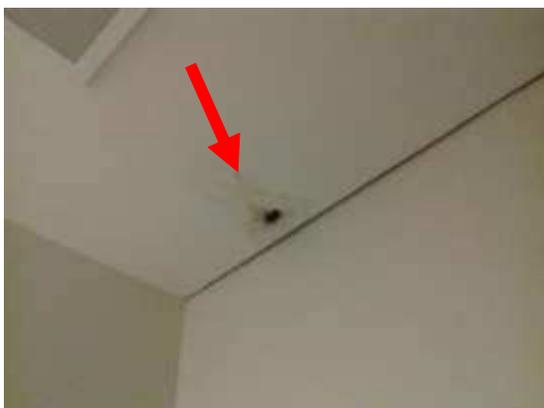
**Imagem 31:** 4º Pavimento – Circulação – Recomposição, emassamento e pintura de forro em gesso acartonado.
