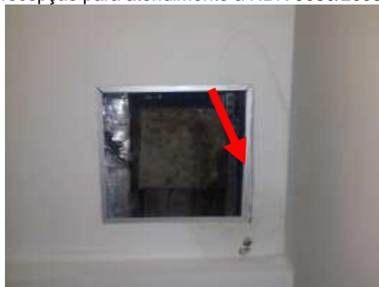
**Imagem 28:** 3º Pavimento – Circulação – Recomposição, emassamento e pintura de forro em gesso acartonado.
