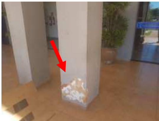
**Imagem 2:** Fachada Leste – Corrigir revestimento argamassado dos pilares. Pintura dos pilares e capitéis.
