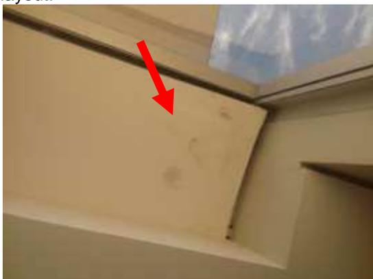
**Imagem 27:** 2º Pavimento – WC Masculino PNE – Recomposição, emassamento e pintura de forro em gesso acartonado.
