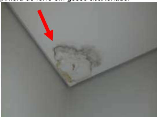
**Imagem 29:** 3º Pavimento – WC ASCOM – Recomposição, emassamento e pintura de forro em gesso acartonado.
