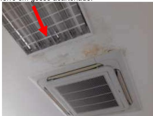
**Imagem 30:** 3º Pavimento – Gabinete DIREF – Recomposição, emassamento e pintura de forro em gesso acartonado.
