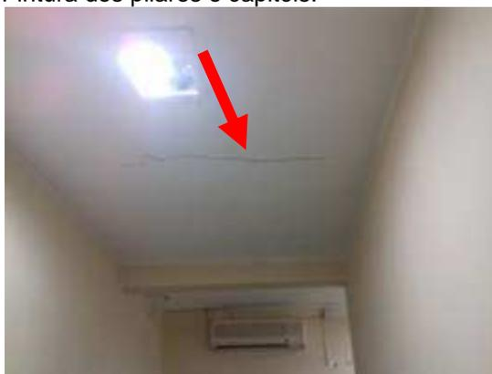
**Imagem 4:** Circulação (Biblioteca) – Remoção de forro em placas/ instalar forro de gesso acartonado, executar emassamento e pintura.
