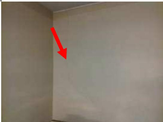
**Imagem 11:** Restaurante – Corrigir trinca escalonada na parede.
