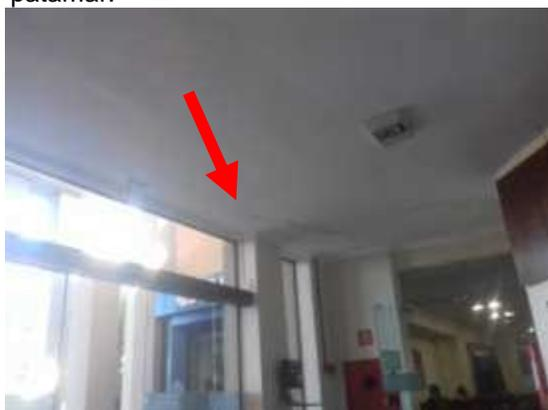
**Imagem 3:** Recepção/Espera – Remoção de forro em placas/ instalar forro de gesso acartonado, executar emassamento e pintura.
