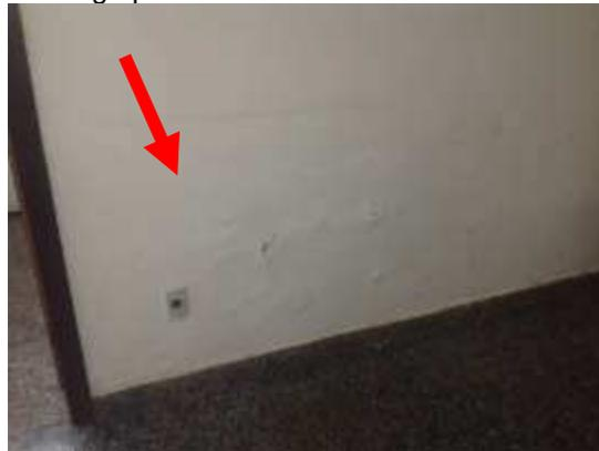
**Imagem 10:** Restaurante – Corrigir infiltração na parede.
