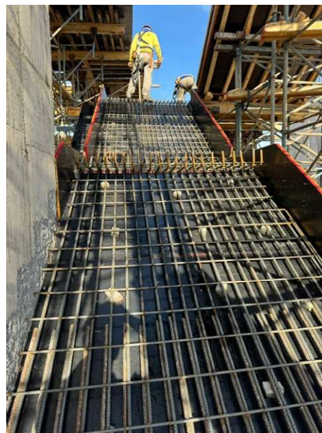
Foto 01 –Escada de concreto armado do 1ª pavimento para o 2ª pavimento.
