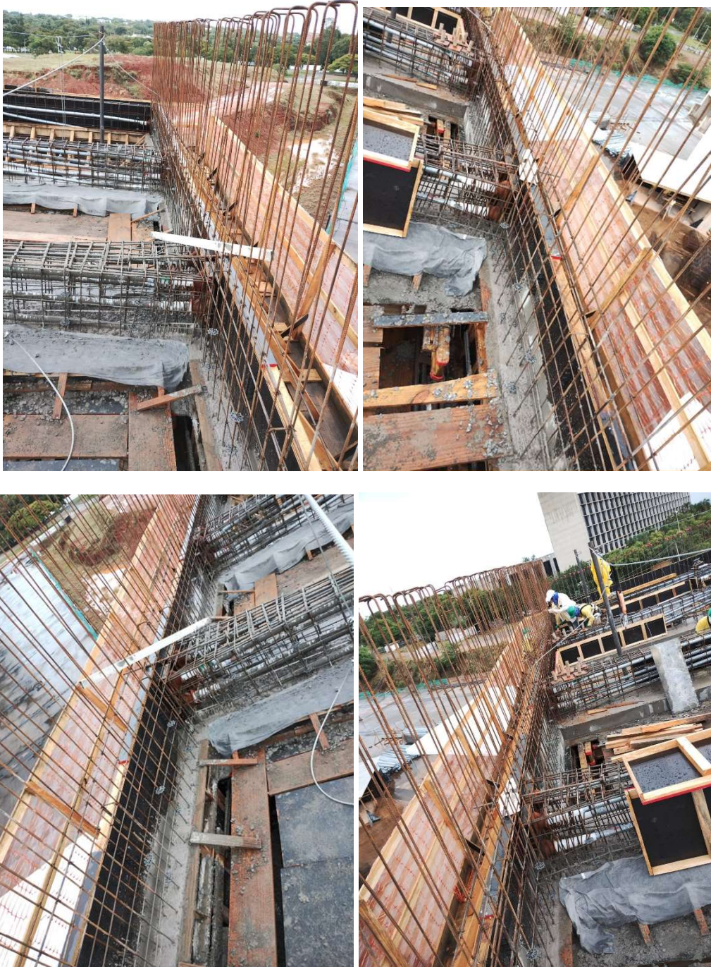
Foto 04 – Paredes e pilares de concreto armado.
