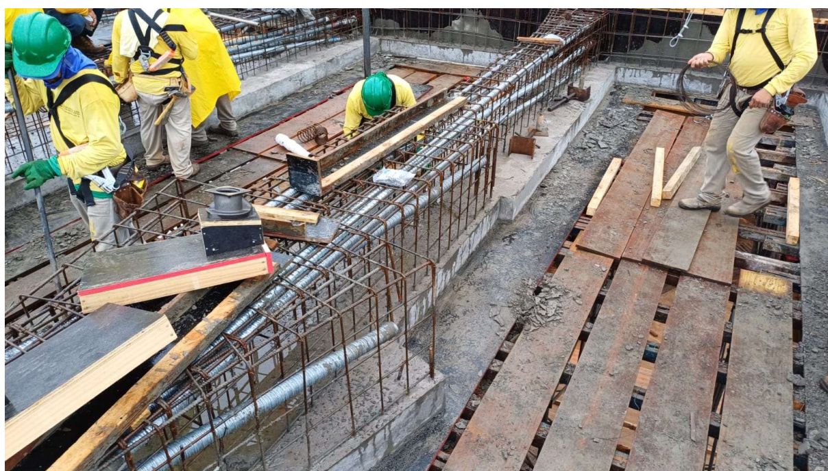
Foto 07 – Vigas de concreto armado.
