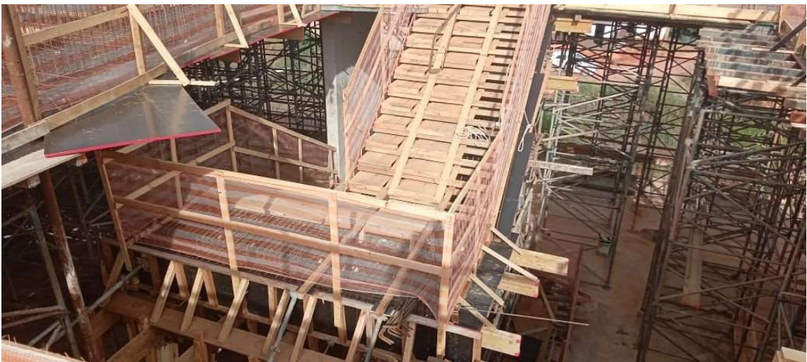
Foto 02 – Escada de concreto armado do 1ª pavimento para o 2ª pavimento.
