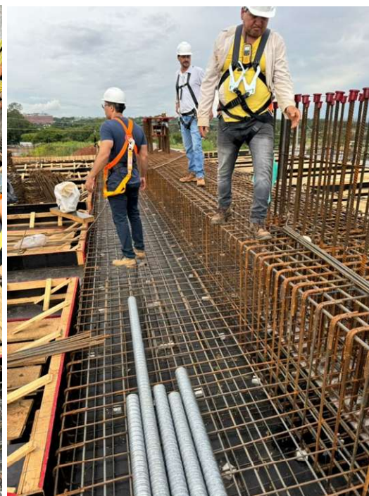
Foto 05 – Vigas de concreto armado.
