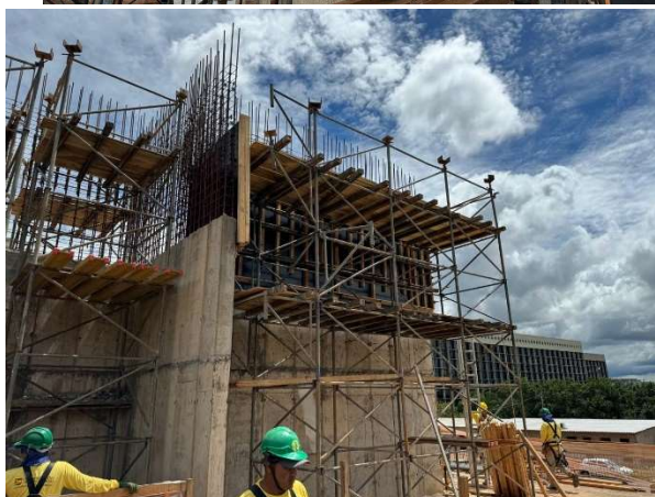
Foto 03 – Complemento de pilar para alcançar os 6,55m de pé direito
