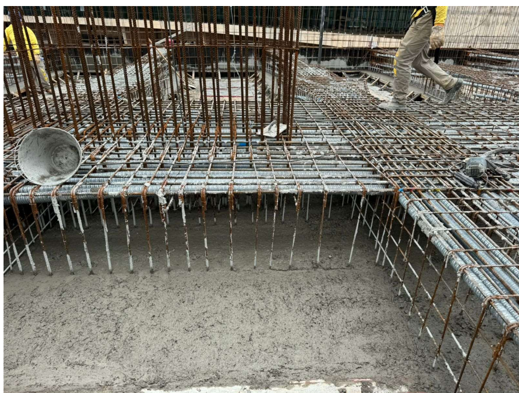
Foto 06 – Vigas de concreto armado.
