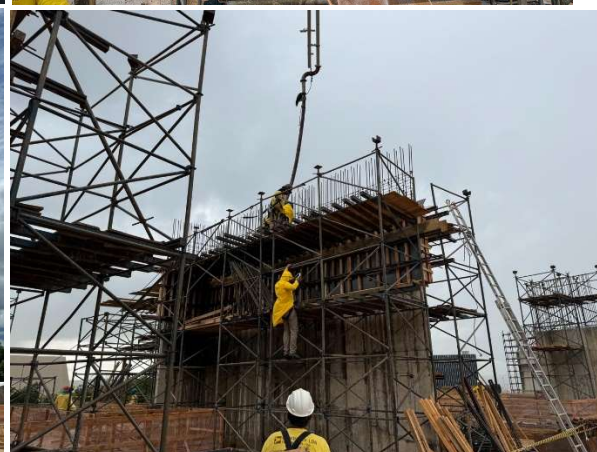
Foto 03 – Complemento de pilar para alcançar os 6,55m de pé direito
