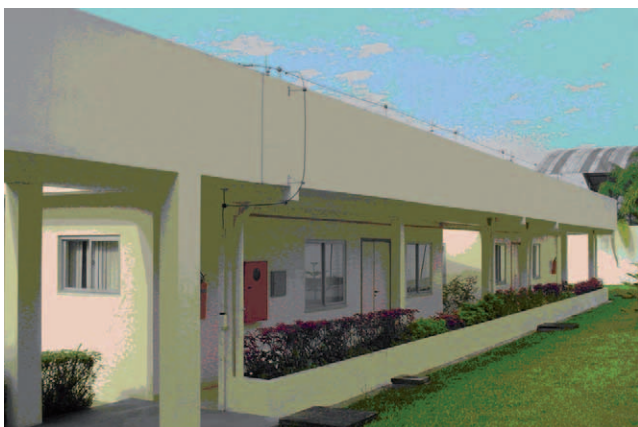
Alojamento dos juizes na Subseção Judiciária de Tabatinga/AM, reformado para instalação da central e rede de distribuição de GLP e construção do muro perimetral.
