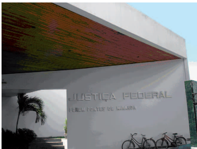
Edifício Sede da Subseção Judiciária de Macapá/AP, reformado em maio para reforço da estrutura.
