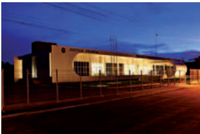
Prédio novo da Subseção Judiciária de Caxias/MA.
