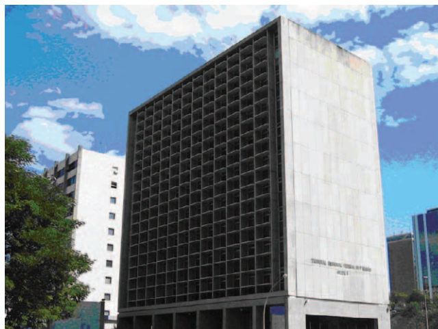
Edifício Sede II do Tribunal, reformado — instalação de dez gabinetes de desembargadores federais.
