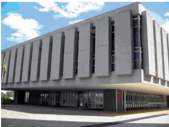
Edifício Sede I do Tribunal, reformado — pintura da fachada, impermeabilização da cobertura e ampliação dos gabinetes de desembargadores federais.
